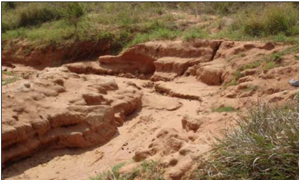
Fig. 4.26 Ravinas próximo do afloramento, causadas pelas chuvas do ano 2000 (miradouro de Marracuene).
